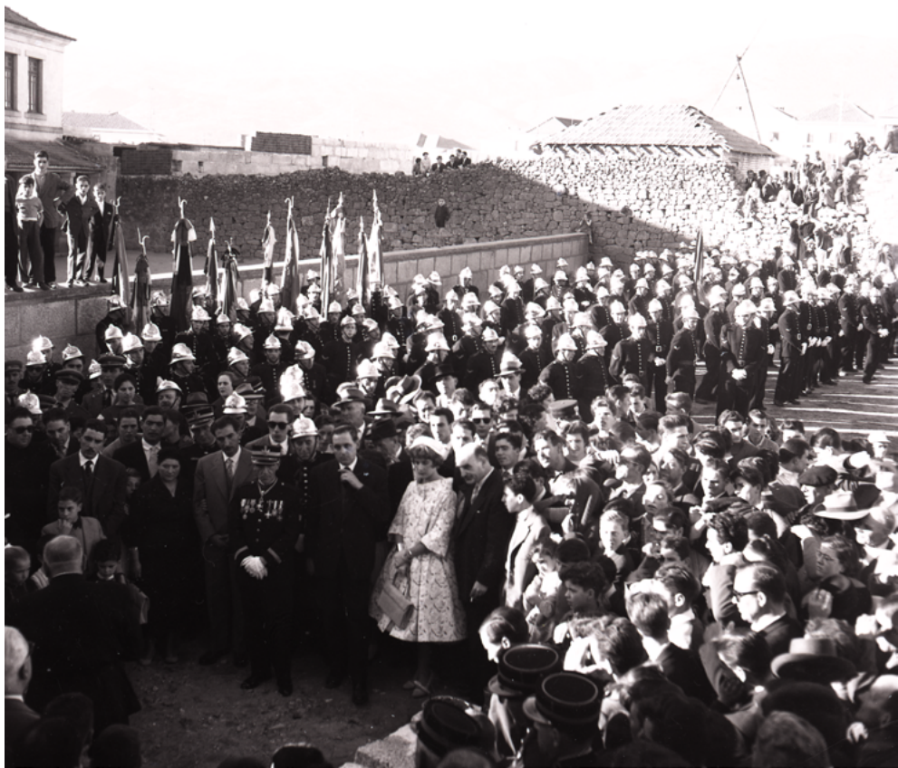
Colocação da “primeira pedra” do quartel Arantes e Oliveira, 1958-10-26 (Coleção Achilles de Almeida)
